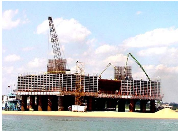
Para o bloco da Torre P.25, que tem dimensões exatamente iguais ao Bloco da Torre P30, realizou-se uma análise conjunta entre, ODEBRECHT, Furnas e Figueiredo Ferraz, em torno da questão relacionada com a profundidade das estacas desta estrutura (menores que as demais), o que tornou esta estrutura mais rígida e, portanto mais desfavorável às deformações térmicas.
