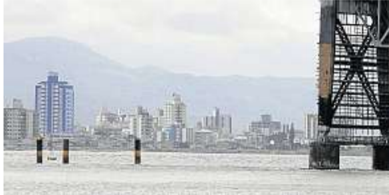
Onde deveria haver um agrupamento de quatro estacas restaram três
