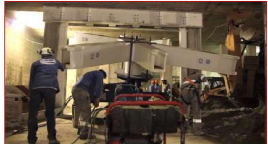
Transferência de carga com pórtico metálico para a passagem do conjunto “árvore + carrinho para o local de instalação.
