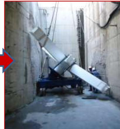
3- Acima com uma angulação de  $43^\circ$  para descer no poço de ventilação e abaixo com a angulação de  $47^\circ$  em outro sentido para o traslado dentro do túnel até a posição de instalação.
