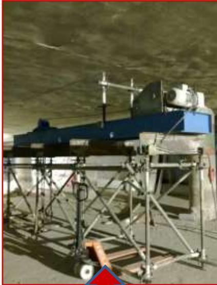
lçamento da “árvore” através de moitão metálico e estrutura tubular com multiplicador de polias para capacidade de 14 toneladas
