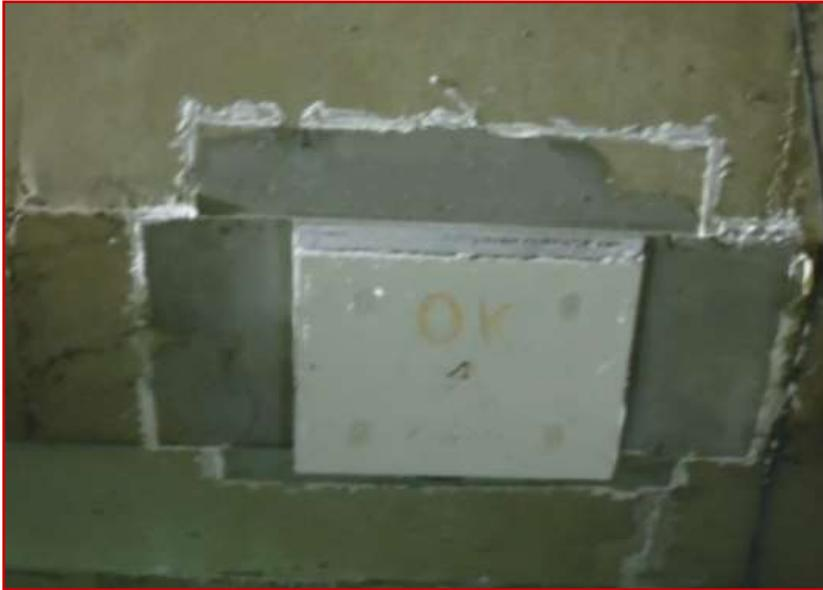
Placa metálica de regularização para apoio de esforços do “braço da árvore” na mísula de concreto.
