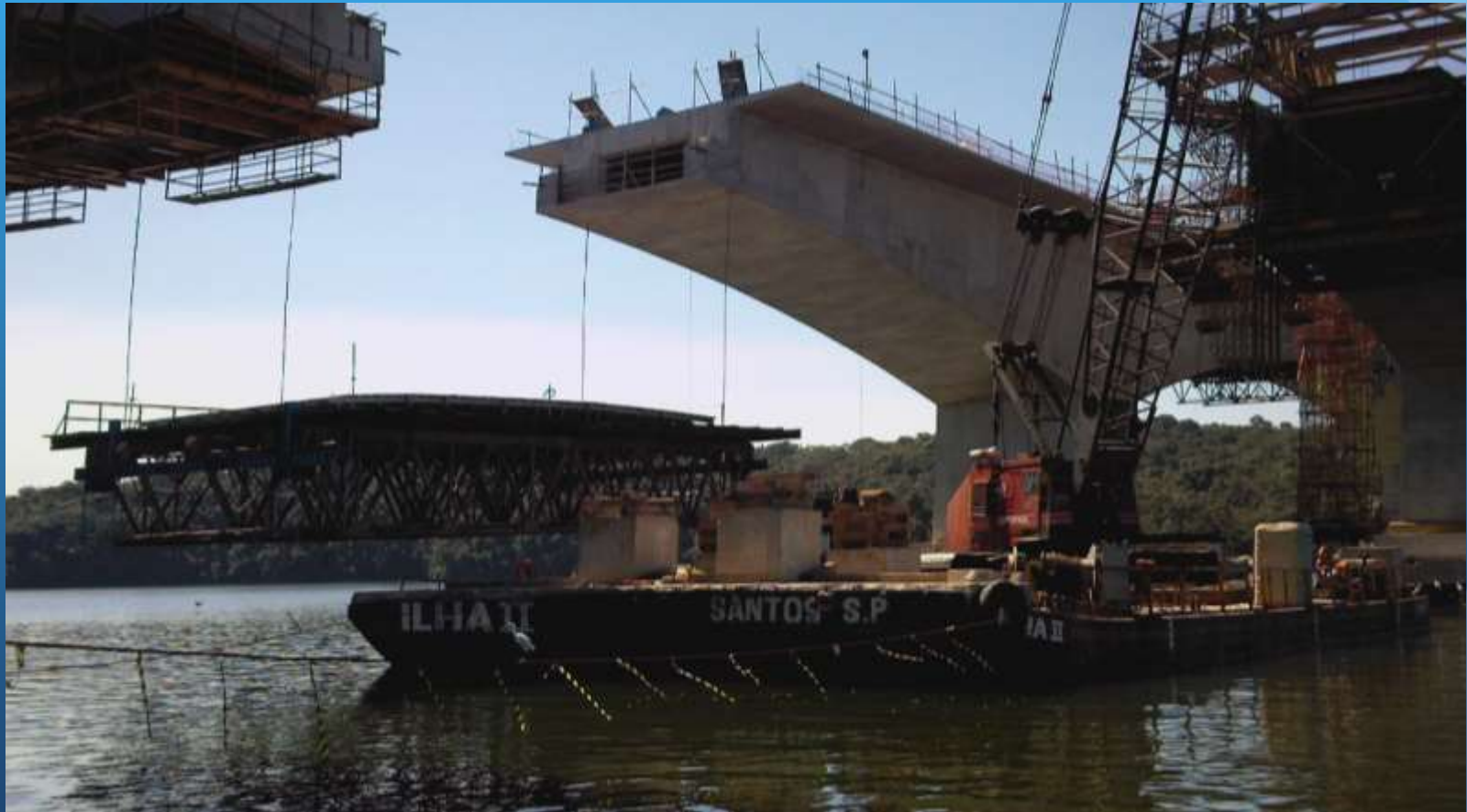
Rodoanel - São Bernardo do Campo - SP - Içamento da plataforma do vão central com 100 t
