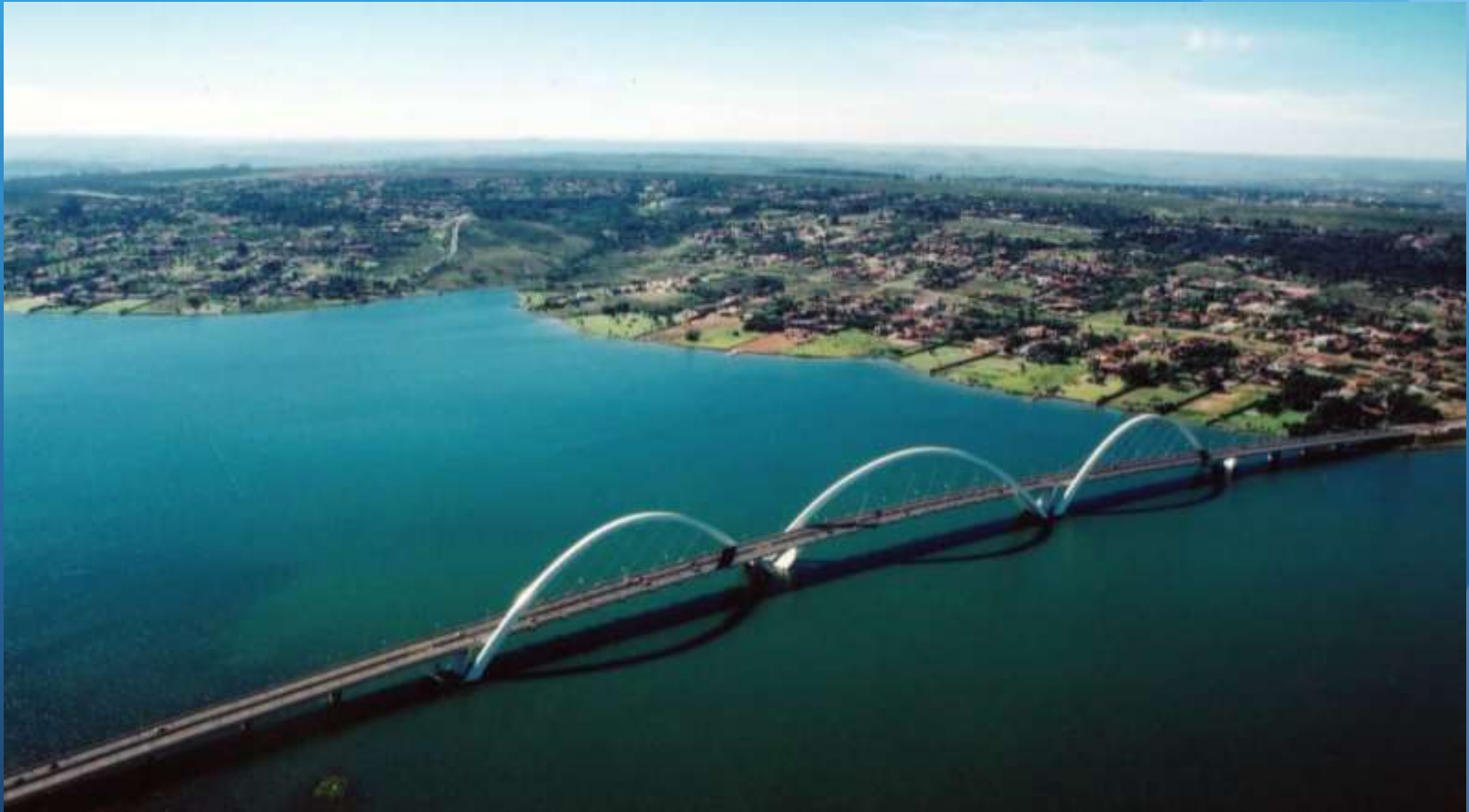
Ponte JK - Brasília - DF - Rebaixamento dos blocos de fundação com 2.500 t
