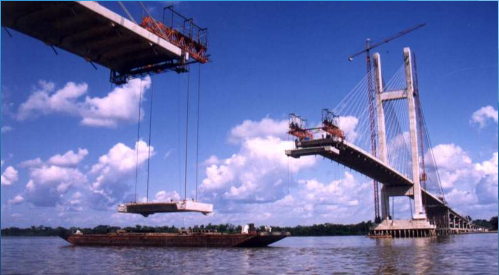
Ponte Guamá- Belém - PA - Içamento de aduelas pré-moldadas com 170 t
