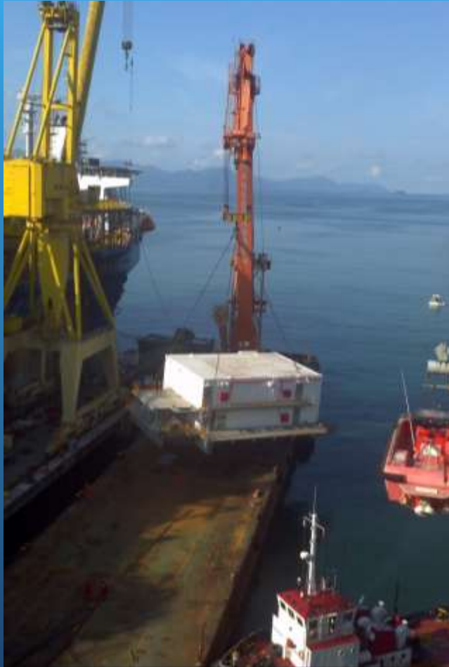
Estaleiro Brasfels - Angra dos Reis - RJ - Içamento do módulo casaria da plataforma Ocean Quest com 250 t
